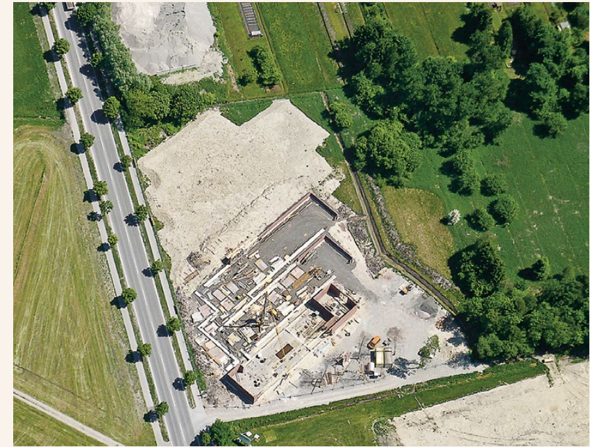
Luftbild des Baugeländes und der Baustelle, 2011.
